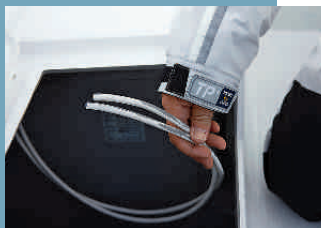
Vorbereitet: Kabel für den Stromkreis
